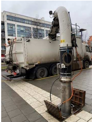
Sugbilen utanför Lugnets Allé 52
